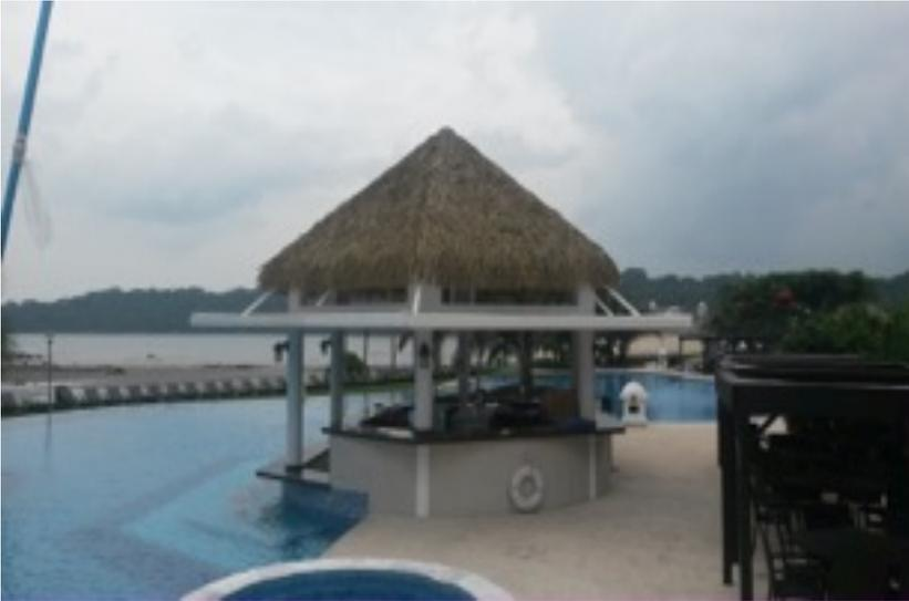
Estructura elaborada en Madera Aserrada, distancia entre columnas de 3mts. Palmex referencia Rio a 35°, Tablilla machimbrada de 1pulg, Alero de 60 cm perimetral.
