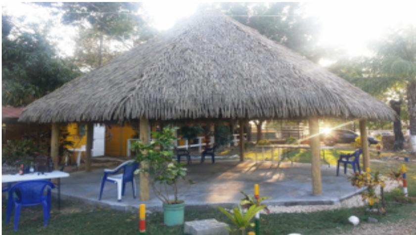
Estructura elaborada en Madera Redonda, distancia entre columnas de 3mts. Palmex referencia Aloha a 35°, Alero de 60 cm perimetral.
