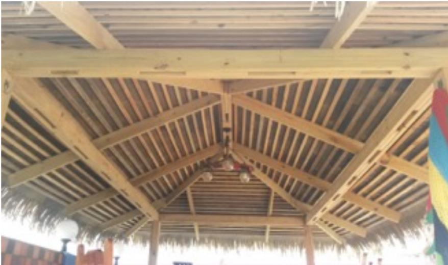
Su estructura es elaborada en Madera Aserrada, distancia entre columnas de 5m X 3m. Palmex referencia Rio a 25°, Alero de 60cm perimetral.
